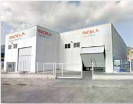
Fachada calle de Llevant
